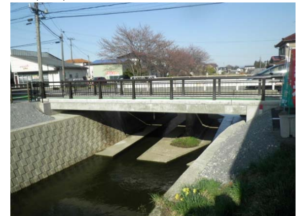
完成(After) 側面
