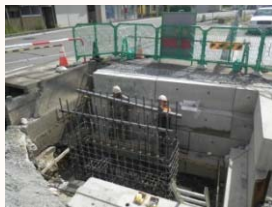
桁下面型枠設置状況
