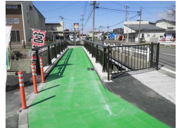
完成(After) 正面
