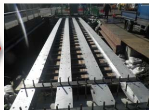
桁下面型枠設置状況
