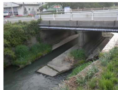
施工前(Before) 側面
