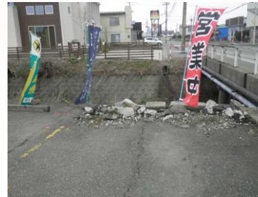
施工前(Before) 正面
