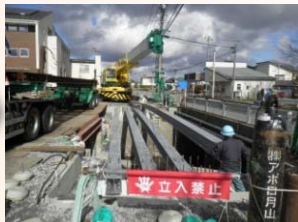
H鋼桁架設状況
