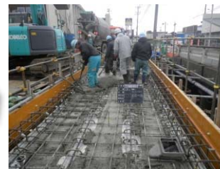
橋体Co打設状況
