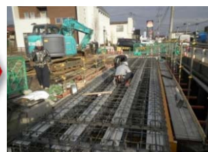
桁上面鉄筋組立状況
