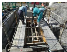
桁上面鉄筋組立状況
