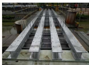
桁下面型枠設置状況
