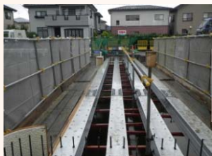
H鋼桁架設状況
