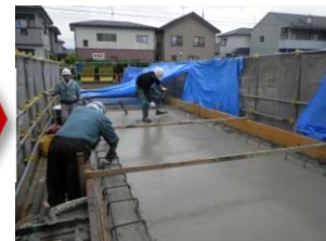
橋体Co打設状況
