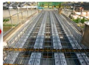
桁上面鉄筋組立状況
