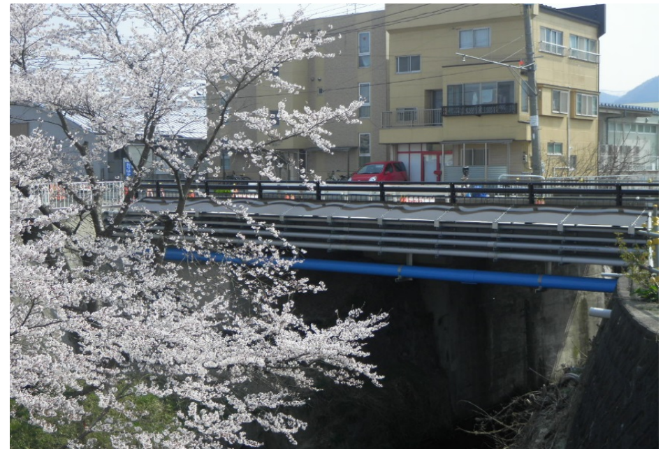
完成(After) 側面
