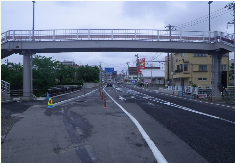
完成(After) 正面
