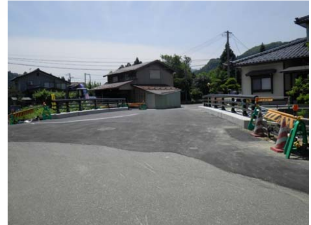
完成(After) 正面
