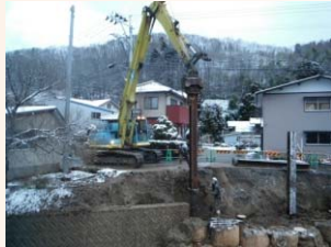
基礎杭の打設状況
