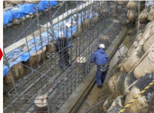
橋台鉄筋組立状況
