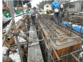
桁上面鉄筋組立状況
