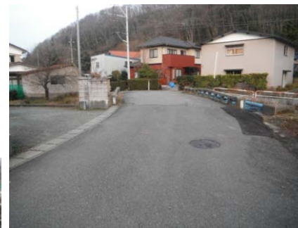
施工前(Before) 側面
