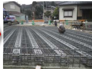
桁上面鉄筋組立状況
