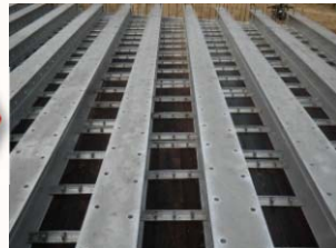
桁下面型枠設置状況
