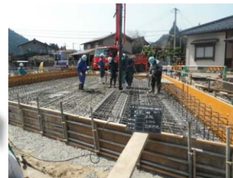
橋体Co打設状況
