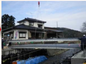
H鋼桁架設状況
