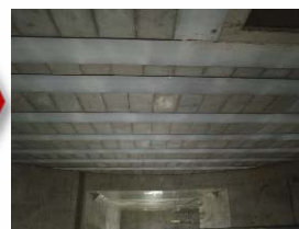
Co打後桁裏面状況
