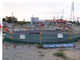
桁上面鉄筋組立状況
