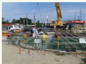
H鋼桁架設状況
