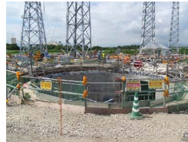
施工前(Before) 側面
