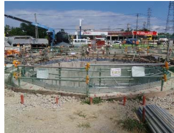
施工前(Before) 正面
