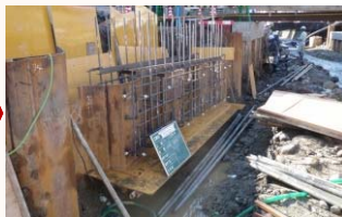
橋台鉄筋組立状況
