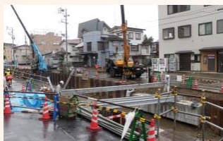
基礎杭の打設状況
