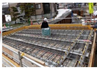
桁上面鉄筋組立状況
