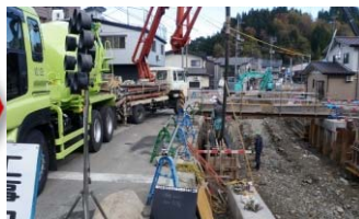
橋台Co打設状況
