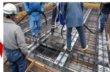
橋体Co打設状況
