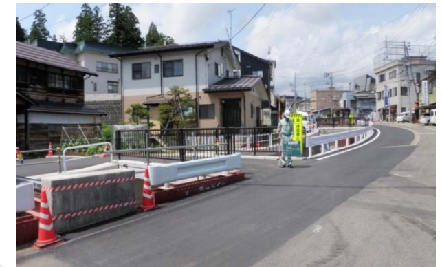
完成(After) 側面
