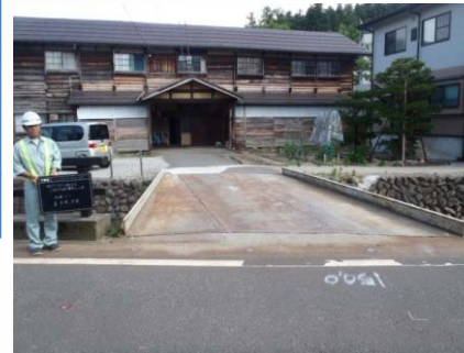
施工前(Before) 正面
