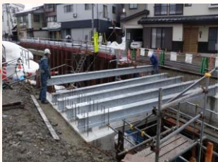
H鋼桁架設状況
