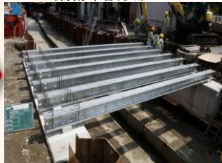
H鋼桁架設状況
