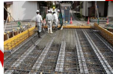
橋体Co打設状況
