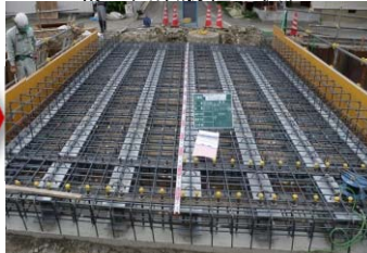
桁上面鉄筋組立状況
