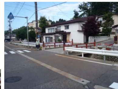
施工前(Before) 側面
