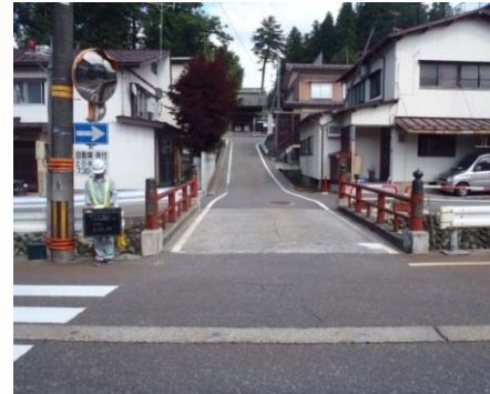
施工前(Before) 正面
