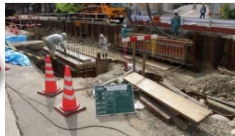
橋台Co打設状況
