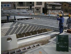
H鋼桁架設状況
