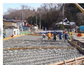
橋体Co打設状況
