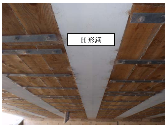
写真-4.1.1 主桁下面（H鋼桁）
