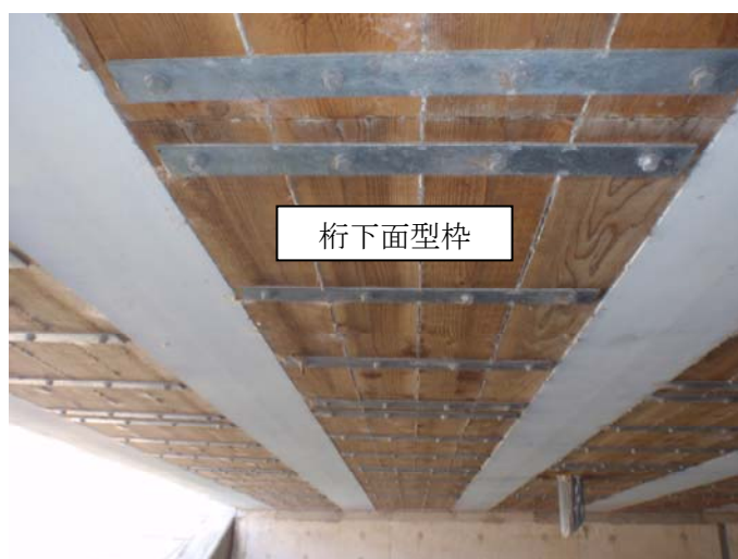
写真-4.1.3 桁下面型枠(杉板を用いた場合)
