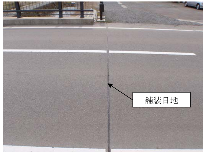
写真-4.1.7 舗装目地
