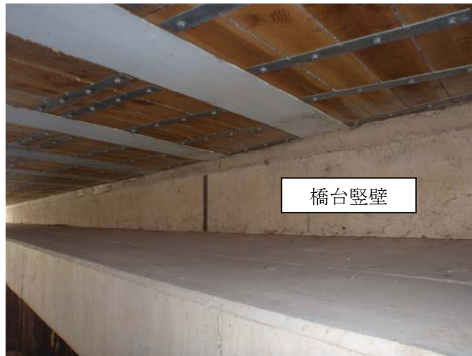
写真-4.1.5 縦壁(橋台)
