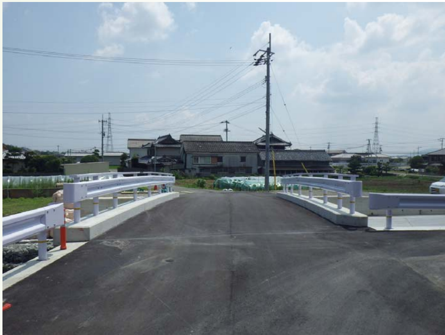
完成(After) 正面
