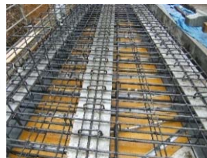
桁上面鉄筋組立状況
