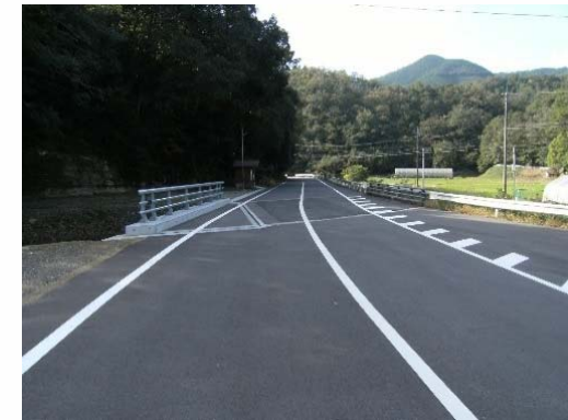
完成(After) 正面
