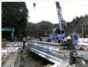
H鋼桁架設状況
