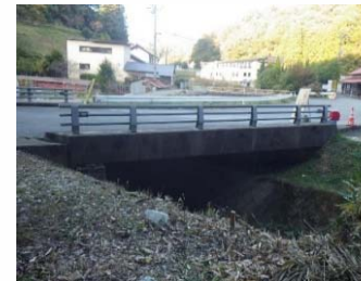
施工前(Before) 側面
