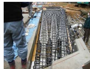
橋体Co打設状況
