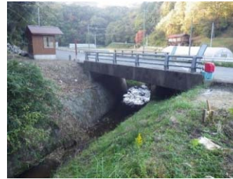
施工前(Before) 正面
