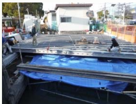
H鋼桁架設状況
