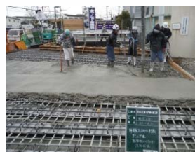
橋体Co打設状況
