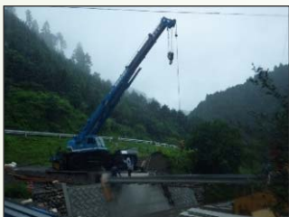
H鋼桁架設状況
