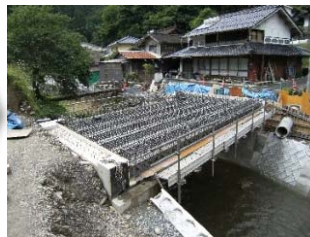
桁上面鉄筋組立状況
