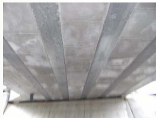
桁下面型枠設置状況
