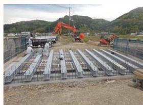
桁上面鉄筋組立状況
