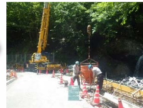
橋体Co打設状況
