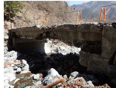
施工前(Before) 側面
