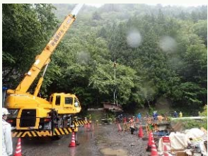
H鋼桁架設状況
