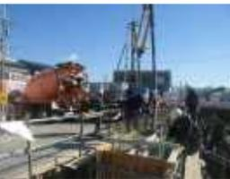
H鋼桁架設状況
