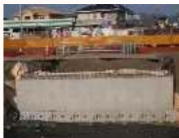
桁下面型枠設置状況
