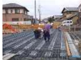
桁上面鉄筋組立状況
