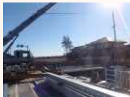
H鋼桁架設状況
