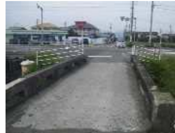
施工前(Before) 正面
