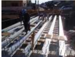
桁下面型枠設置状況
