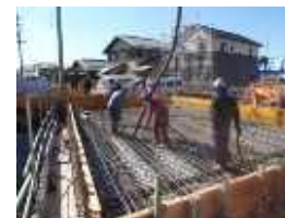
橋体Co打設状況
