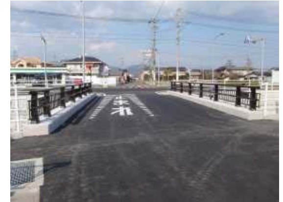
完成(After) 正面
