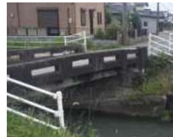
施工前(Before) 側面
