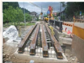
H鋼桁架設状況
