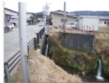
施工前(Before) 正面
