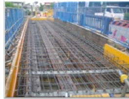
桁上面鉄筋組立状況
