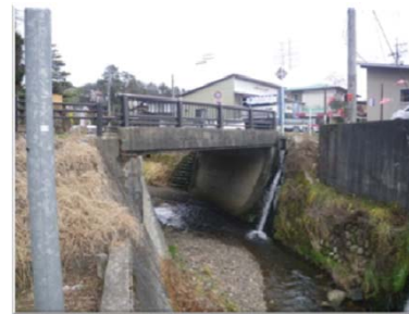
施工前(Before) 側面
