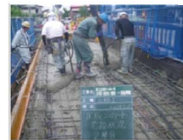
橋体Co打設状況
