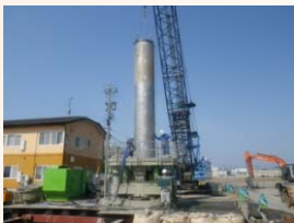
基礎杭の打設状況
