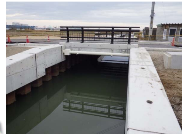
完成(After) 側面
