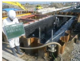
橋台鉄筋組立状況
