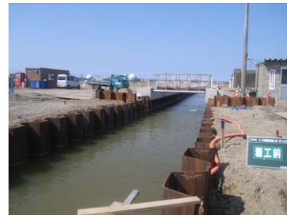
施工前(Before) 側面
