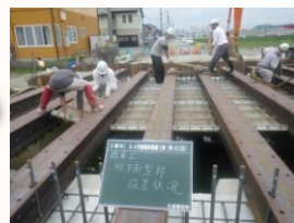
桁下面型枠設置状況
