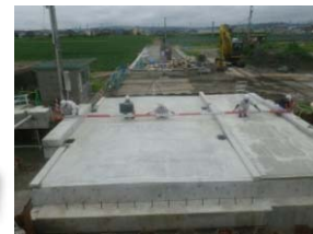
橋体Co打設状況
