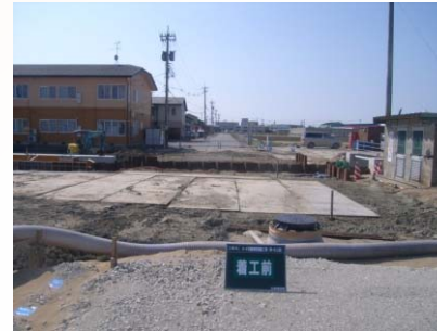
施工前(Before) 正面
