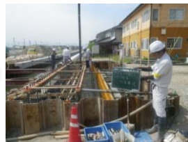
橋台Co打設状況
