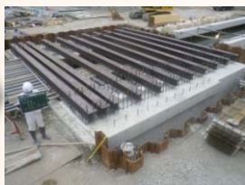
H鋼桁架設状況
