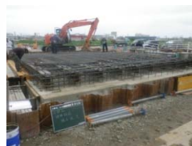
桁上面鉄筋組立状況
