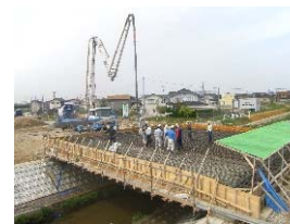
橋体Co打設状況
