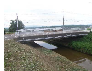
施工前(Before) 側面
