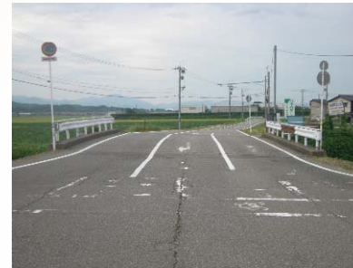
施工前(Before) 正面
