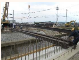
H鋼桁架設状況
