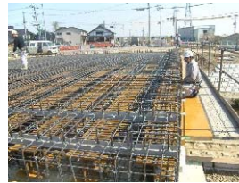
桁上面鉄筋組立状況
