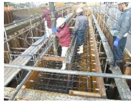
橋台Co打設状況
