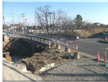
施工前(Before) 正面
