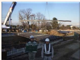
H鋼桁架設状況
