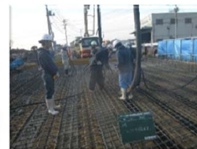
橋体Co打設状況
