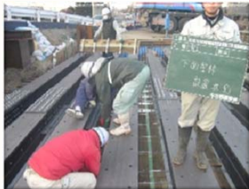
桁下面型枠設置状況
