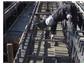
桁上面鉄筋組立状況
