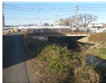
施工前(Before) 側面
