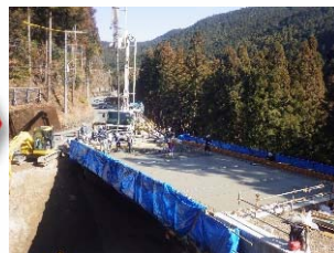
橋体Co打設状況
