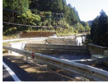
施工前(Before) 正面
