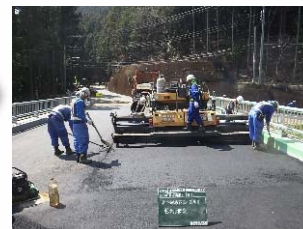
橋面舗装状況
