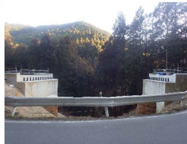
施工前(Before) 側面
