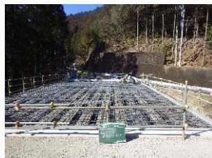
桁上面鉄筋組立状況
