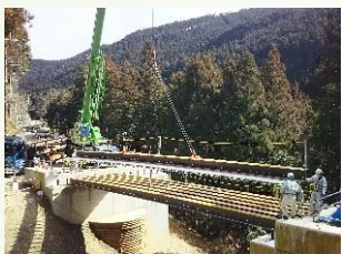
H鋼桁架設状況
