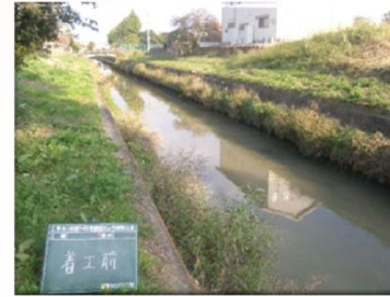
施工前(Before) 正面
