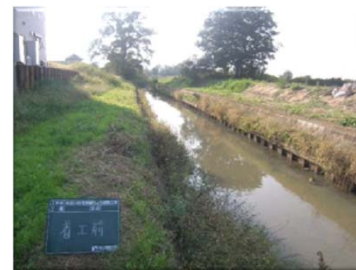
施工前(Before) 側面
