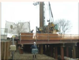
H鋼桁架設状況
