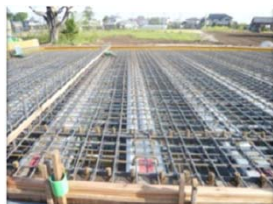
桁上面鉄筋組立状況
