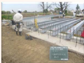
H鋼桁架設状況
