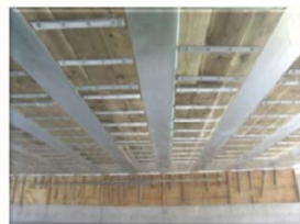
桁下面型枠設置状況
