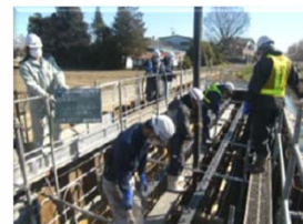
桁上面鉄筋組立状況
