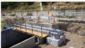
桁下面型枠設置状況(PC板)
