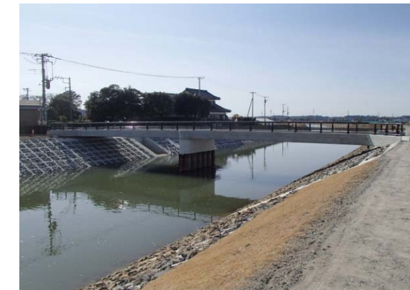
完成(After) 側面
