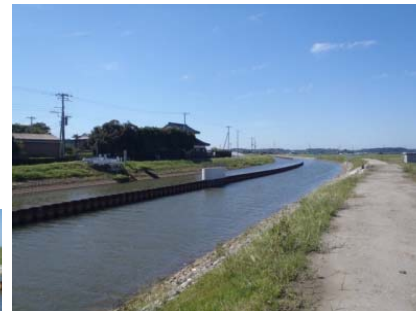
施工前(Before) 側面
