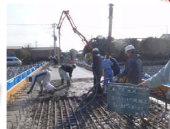
橋体Co打設状況
