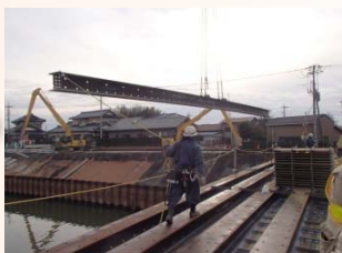
H鋼桁架設状況
