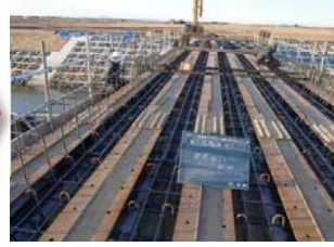
桁上面鉄筋組立状況
