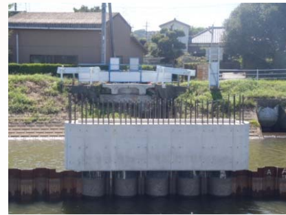
施工前(Before) 正面
