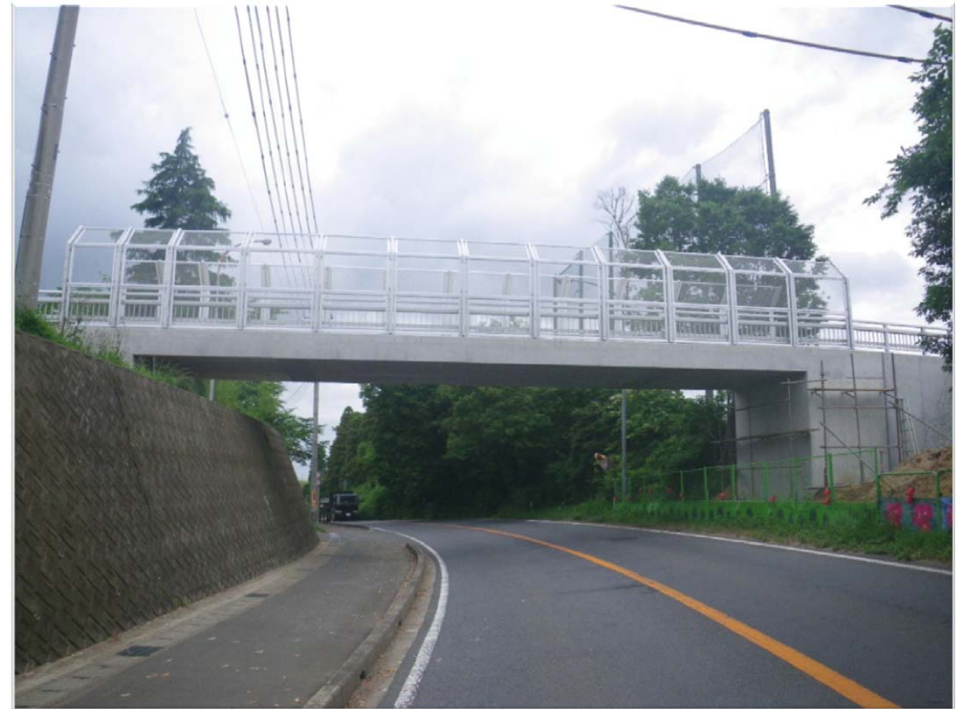
完成(After) 側面
