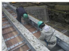
桁下面型枠設置状況
