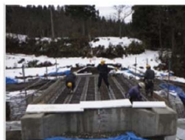
桁上面鉄筋組立状況
