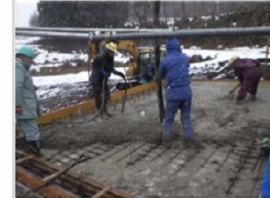
橋体Co打設状況
