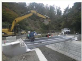
H鋼桁架設状況
