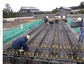
桁上面鉄筋組立状況
