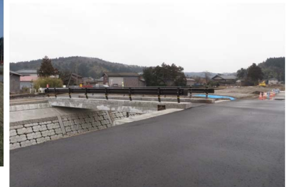
完成(After) 側面
