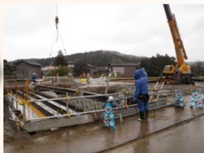
H鋼桁架設状況
