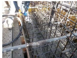
橋台Co打設状況
