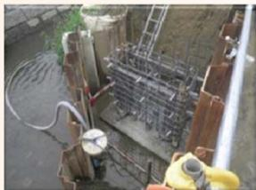
橋台鉄筋組立状況
