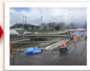
桁下面型枠設置状況
