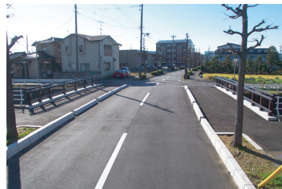
ジョイントレス構造施工例
