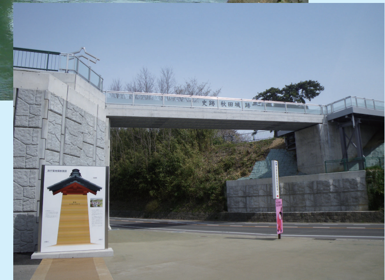
秋田城史跡公園連絡橋 橋長18.60m 秋田県秋田市(令和3年10月架橋)
