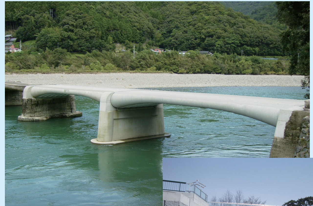
四万十川(屋内大橋) 2径間架替 橋長15.25m 高知県四万十市(平成26年3月架橋)
