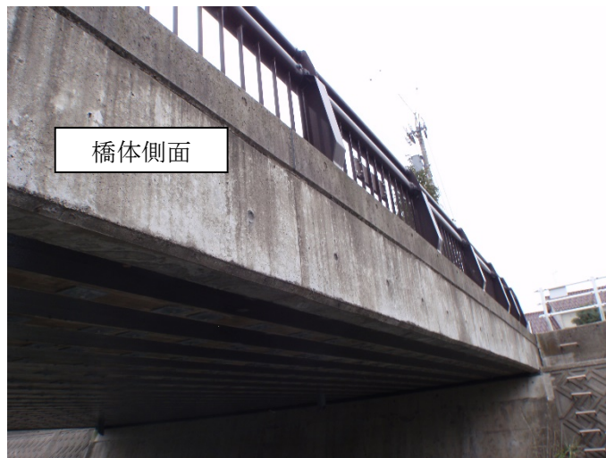
写真-4.1.2 橋体 (側面)
