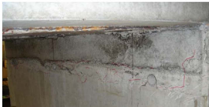
写真-4.5 橋台前面の圧壊
