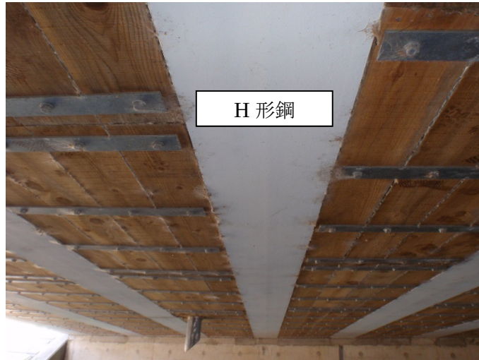
写真-4.1.1 主桁下面 (H鋼桁)
