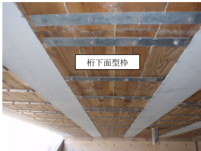
写真-4.1.3 桁下面型枠 (杉板を用いた場合)
