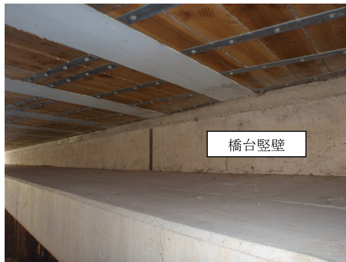
写真-4.1.5 縦壁(橋台)
