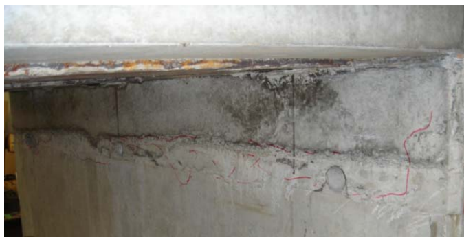
写真-4.6 橋台前面の圧壊，補強桁有，メッキ処理（case2①）
