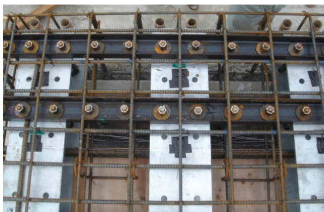
写真-6 H形鋼の設置と鉄筋の配筋（上面より）
