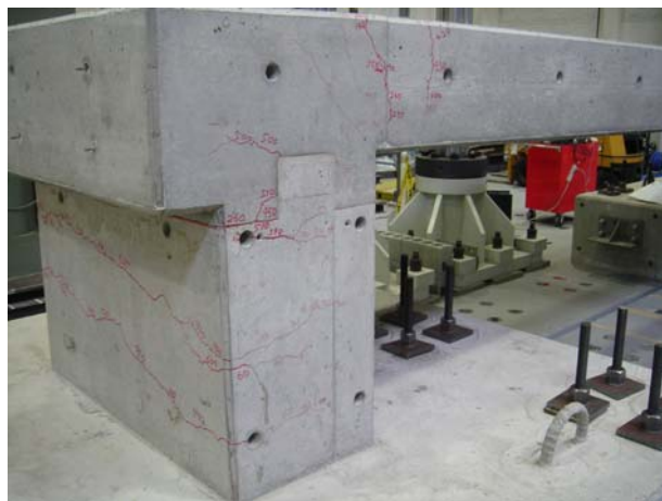
写真-4.9 橋台部の打ち継ぎ部の開き
