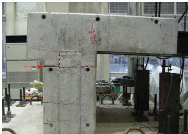
写真-4.13 打ち継ぎ目（点線部）からの開き
