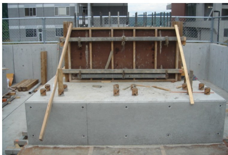
写真-3 橋台部の躯体部の打設
