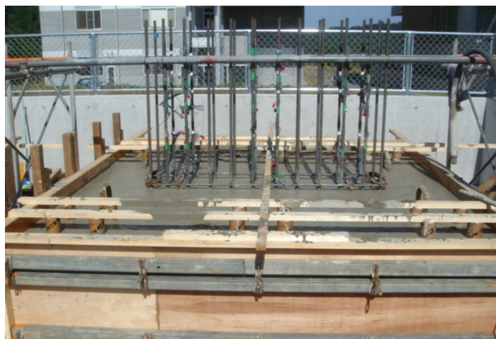
写真-2 橋台部フーチングの打設
