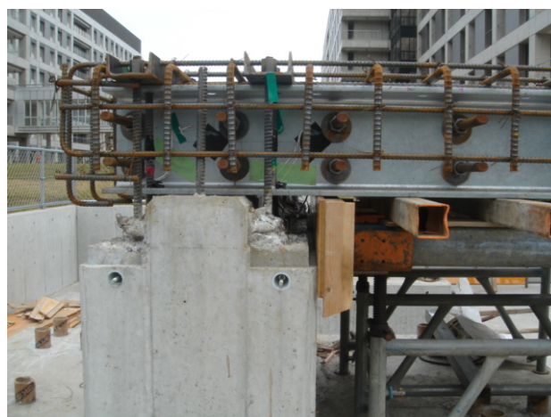
写真-5 H形鋼の設置と鉄筋の配筋（側面より）
