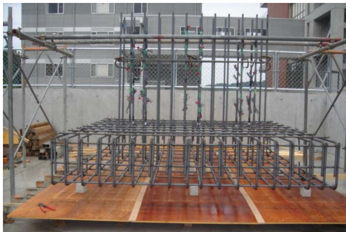
写真-1 橋台部の配筋
