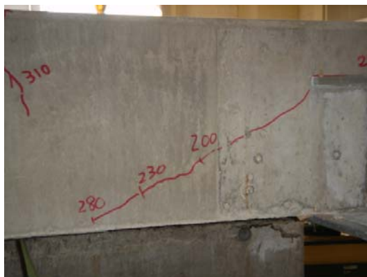
写真-4.5 H形鋼まわり（前面）のひびわれ状況，補強桁有，メッキ処理（case2①）
