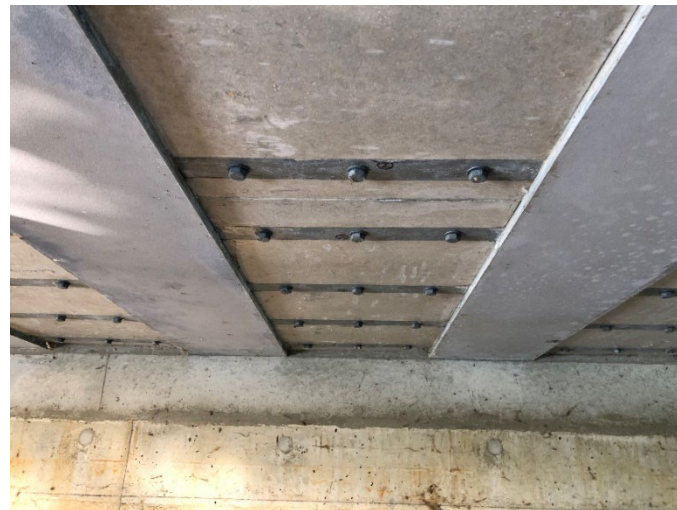
2) 合板型枠材(撤去タイプ)
