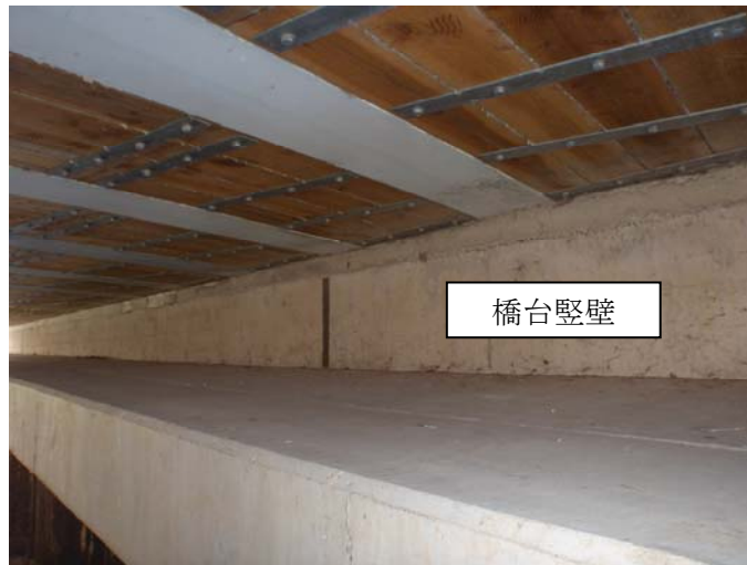
写真-4.1.5 縦壁(橋台)
