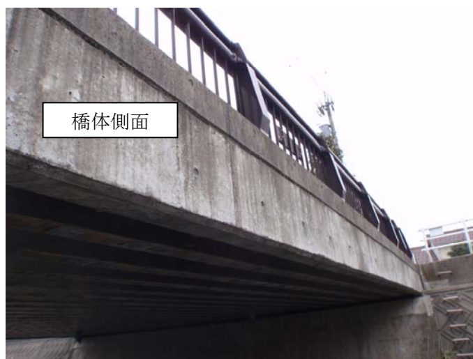
写真-4.1.2 橋体 (側面)
