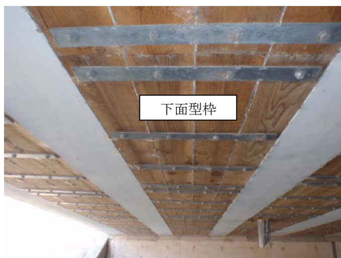
写真-4.1.3 桁下面型枠 (杉板を用いた場合)
