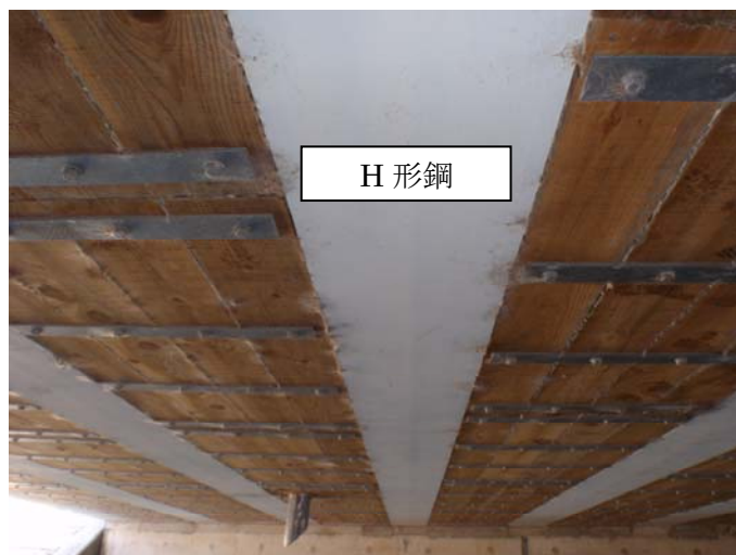
写真-4.1.1 主桁下面 (H鋼桁)
